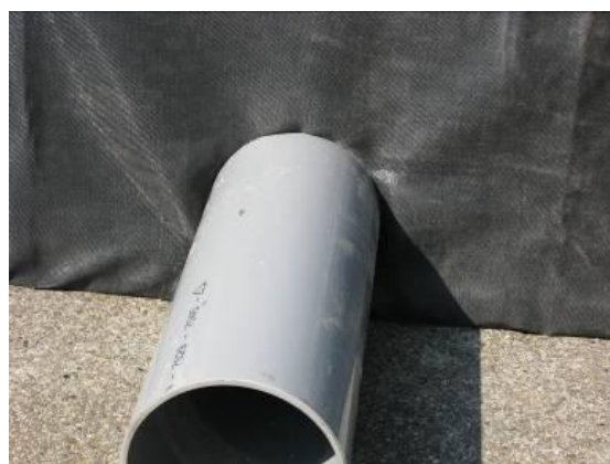
Billede 4: Kobling af rør til kassette.
