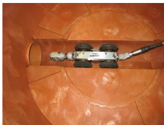
Billede 5: Inspektion med raktordrevet kamera via inspektionsbrønd.
