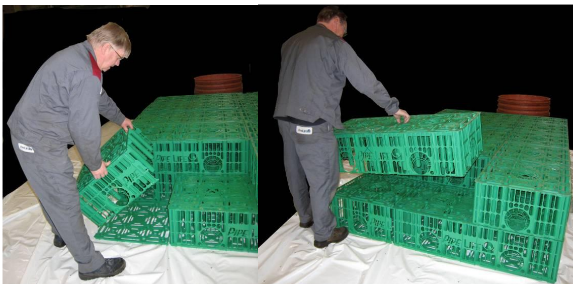
Billede 2a og 2b: Kassetterne kan halveres og indføres i anlægget.
